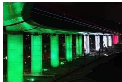
予定通り開通した橋
